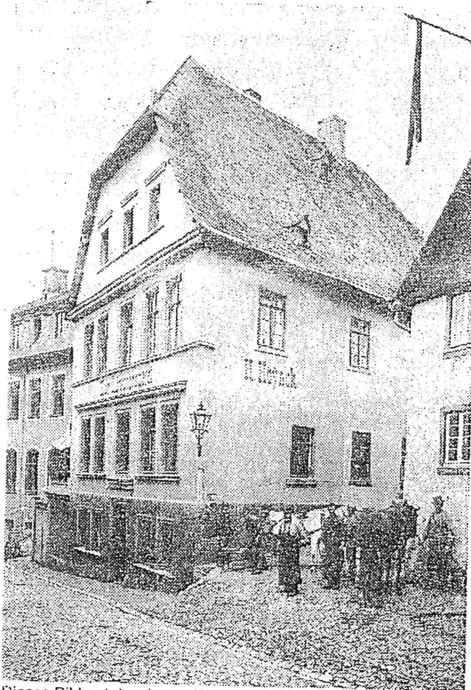
Dieses Bild entstand ungefähr um die Jahrhundertwende. Unterhalb des Gasthofes „Zur Löwenbrauerei“ an der Apostelstraße steht noch das alte Hohkamp'sche Haus.
