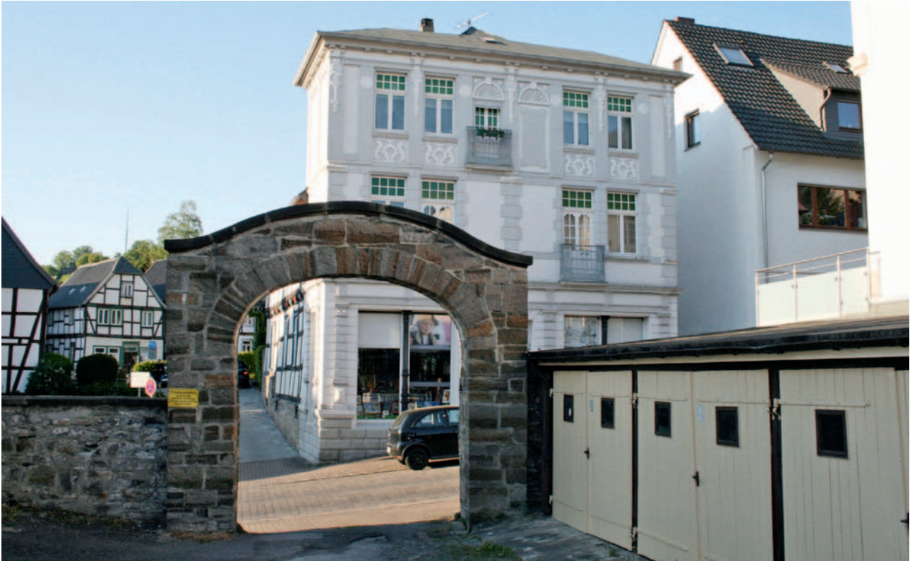
Blick zur Apothekenstraße, Ansicht von Süden (2011)
