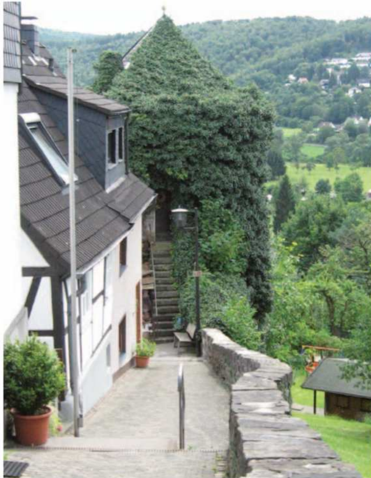
Grüner Turm, Ansicht von Osten (2009).
