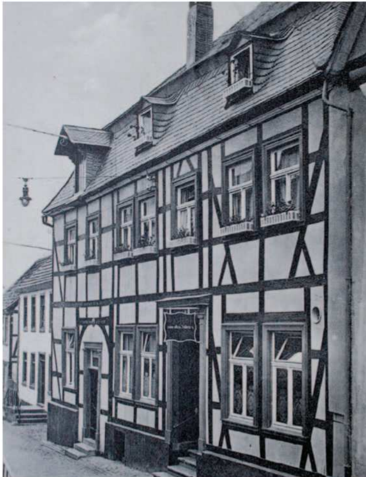
Schloßstraße 21, Blick vom Nordosten (um 1950).
